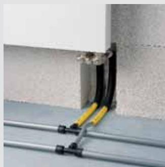
Collegamento di un radiatore al sistema VA®
